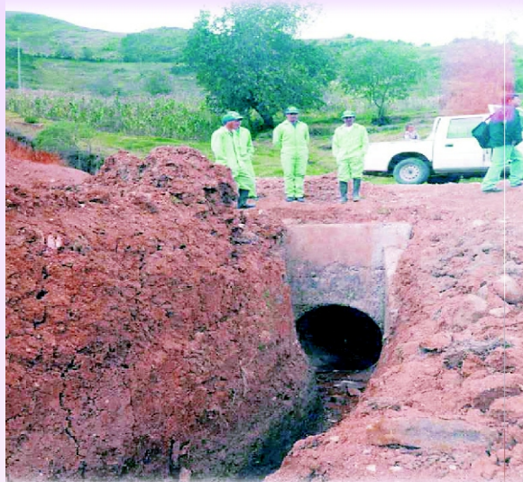
Limpeza de alcantarilla: Microempresa de mantenimiento de caminos en la provincia del Azuay en el Ecuador
