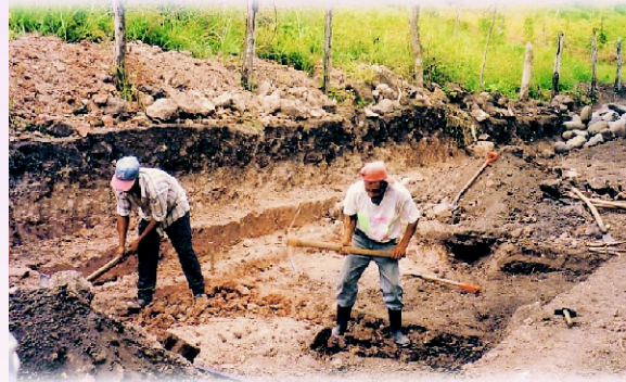
Reparación de camino con uso intensivo de mano de obra.
